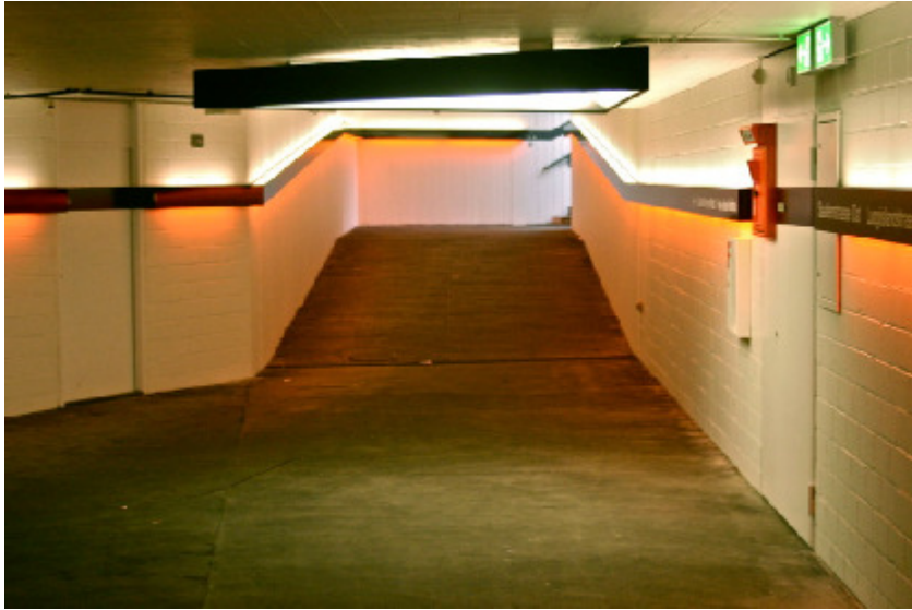
Tramtunnel Haltestelle Schwamendingen, 8051 Zürich
